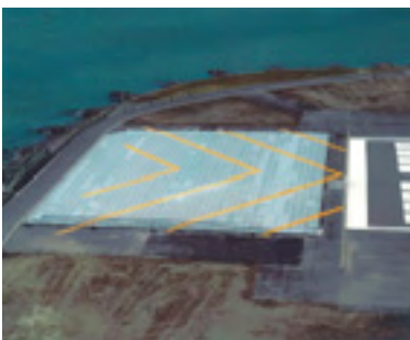
Système Emas d'arrêt d'urgence en bout de piste sur l'aéroport de Boston Logan (États-Unis)
